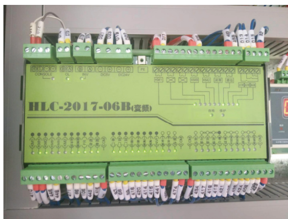
图4.3-1 4S（精英版）逻辑控制器信号灯
