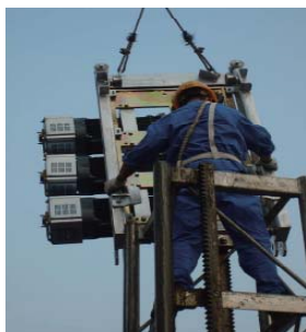
图1.3-8 驱动系统的安装
