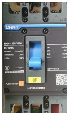
图2.1-1 下电箱断路器（分断状态）
